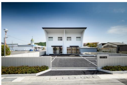
正面からみた外観
